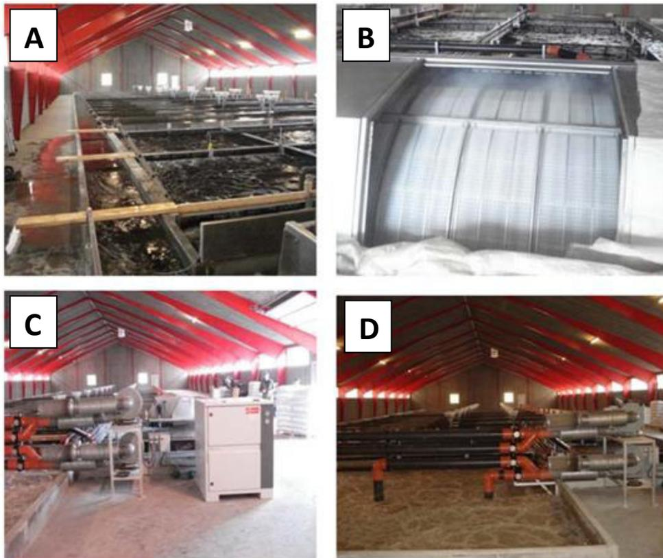
Abbildung 4. Dänische Teil-KLA ©Nielsen „NC Consulting ApS“, A: Ansicht vom Süden des Gebäudes mit Biofiltern im Vordergrund, B: Trommelfilter, C: Capsel und Venturi Blower zu Belüftung und Entgasung, D: Entgasung mit Venturi Blower und Rohrsystem.
